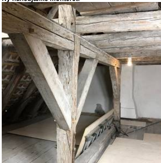
Nyt skræspær monteret
