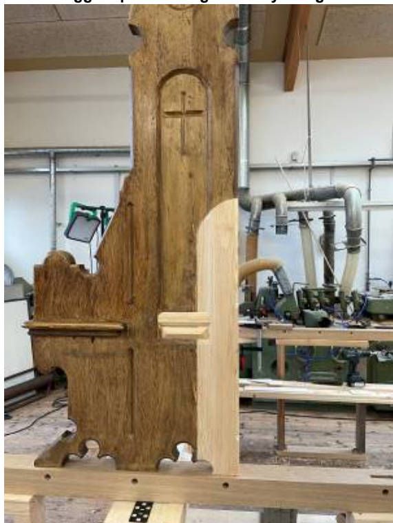
Nye dele fremstilles og monteres, hvor der er skader
