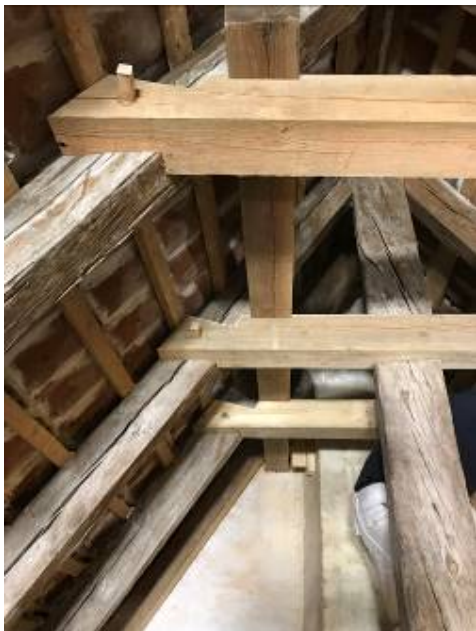
Der opbygges en helt ny tømmerkonstruktion for at sikre, at gavlen fastholdes.
