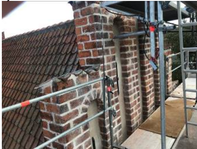
Gavlen er repareret og omfuget
