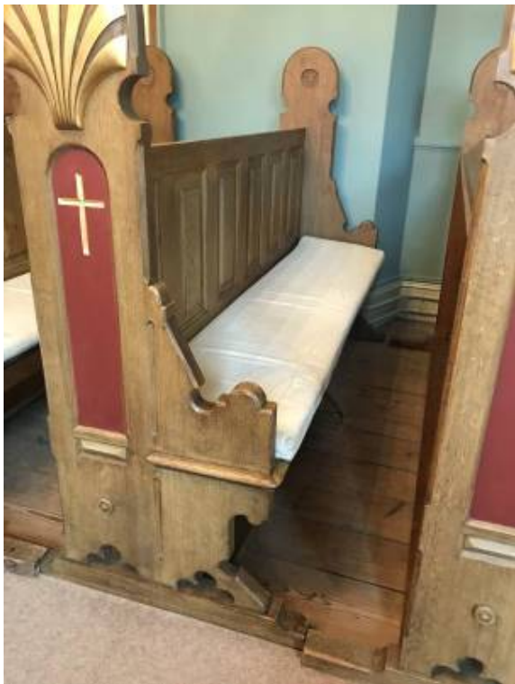
Før: Alle kantremmene savet over mellem hver bæk. Løse, hvide sædepuder.
