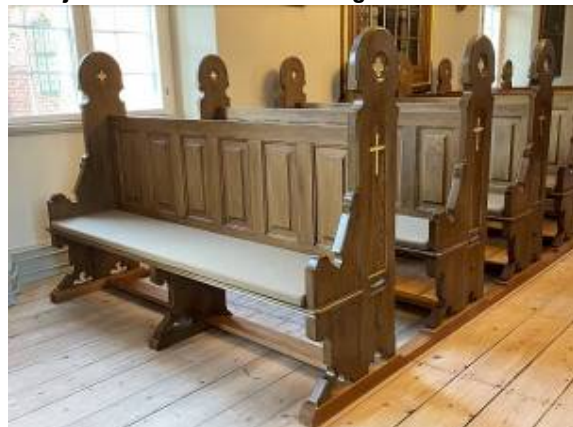
Nyfremstillet forreste bæk monteret på forgavlen af nordre bænkrække som nøjagtig kopi af de originale bænke.
