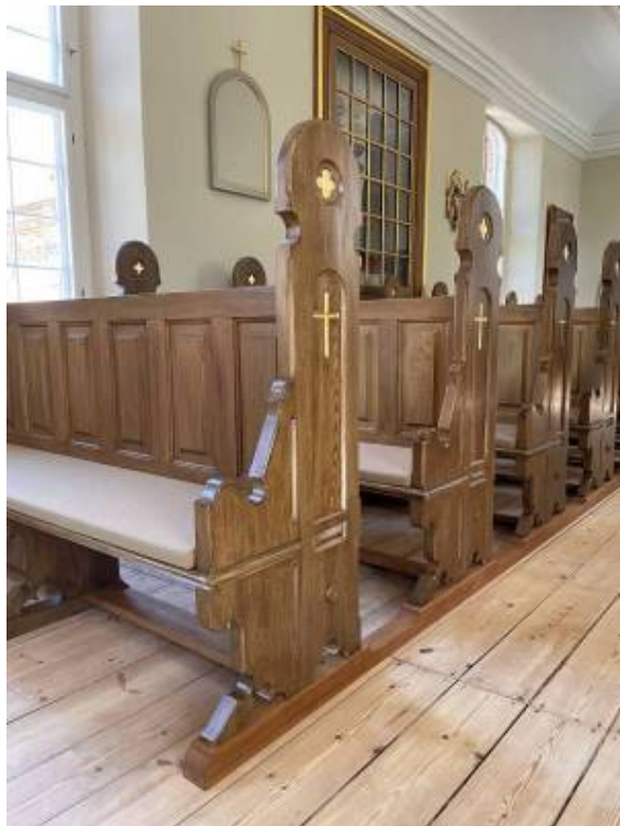
Efter: Bænkene opsat på nye langsgående kantremme i egetræ. Nye skridsikre og faste bænkpuder i naturfarve.
