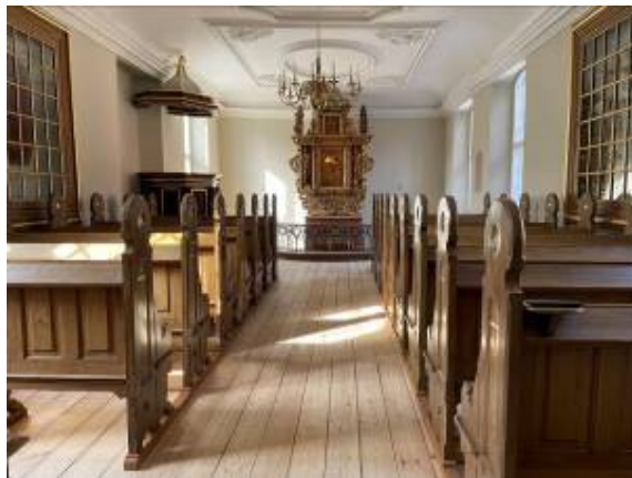
Efter: Gulvtæpper fjernet, gulvet afhøvlet og sæbebehandlet
