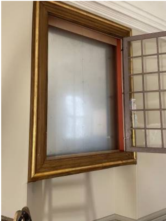
Der opsættes flamingo, finerplade og 2 mm stålplade Pladen males i kontrastfarve
