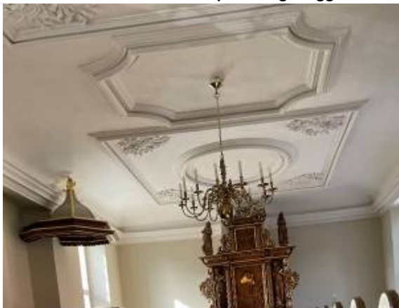
Efter: Loftet repareret, pudset og kalket
