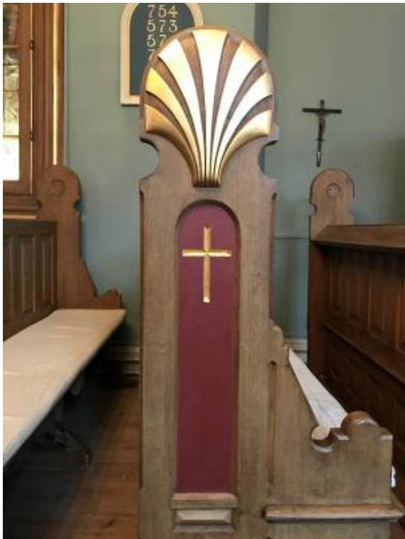
Før: Bænkjavl med uoriginal lbsskal og rød bemaling fra ca. 1960.
