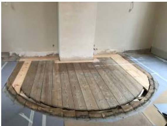
Det gamle korgulv er lagt i niveau med kirkegulvet og suppleret med enkelt gamle brædder fra lager
