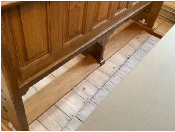
Nye fodbrædder i egetræ, som kan afmonteres for rengøring.
