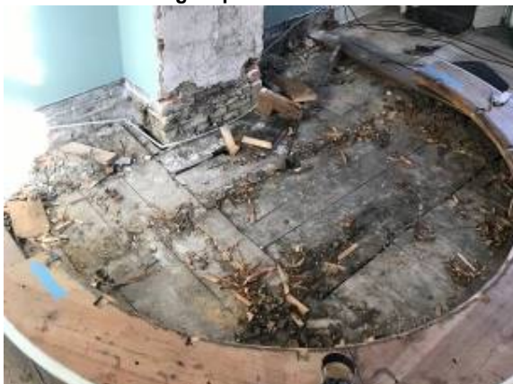
Koret er skåret frit. Et gammelt gulv ligger under korgulvet
