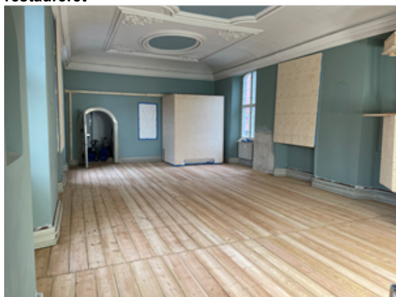
Gulvet er repareret for mange skader, slebet og sæbebehandlet
