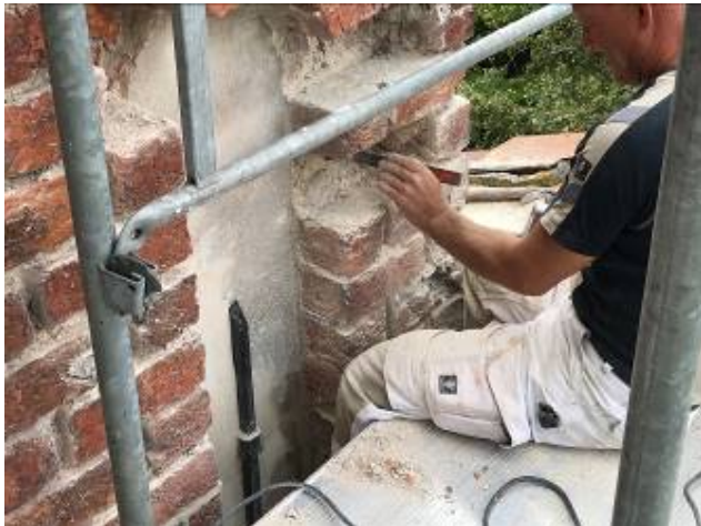
Defekte sten udskiftes med originale munkesten
