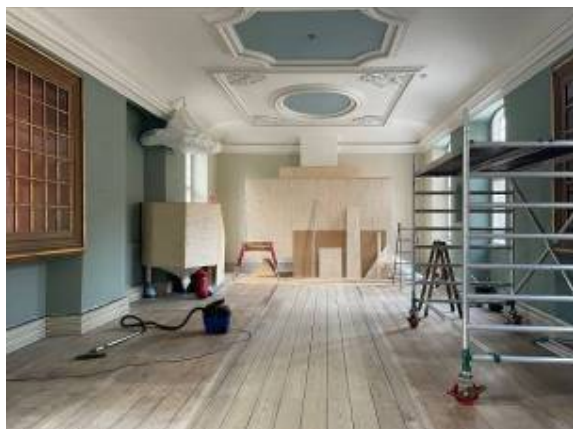
Alt inventar og gulvtæpper er fjernet. Alter, prædikestol og orgel indpakkes i finerkasser.
