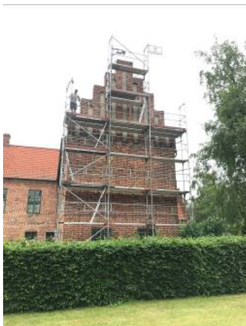
Kirkegavlen måtte først renoveres, da gavlen ikke havde konstruktiv forbindelse til tagværkerne.
