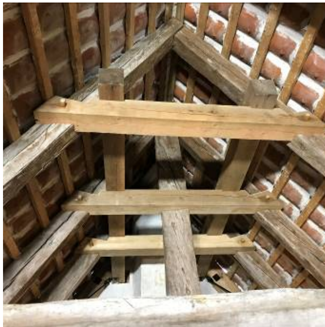
Den færdige konstruktion. Gavlspærrene er yderligere sikret med skråstag i stål i begge sider.
