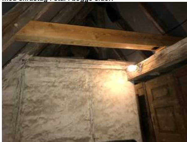
Ny hanebjælke monteret.
