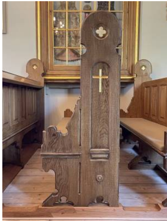
Efter: Bænkjavl tilbageført til original stand. Ny-ådret og forgyldt.
