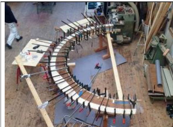
Knæfaldet ombygges med nye understøtninger mv.
