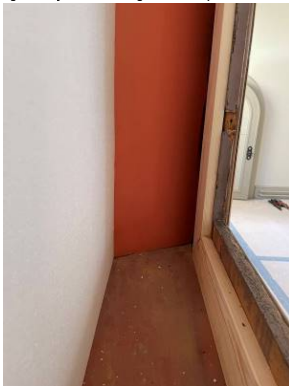
Udstillingsskabene renoveres og forstærkes
